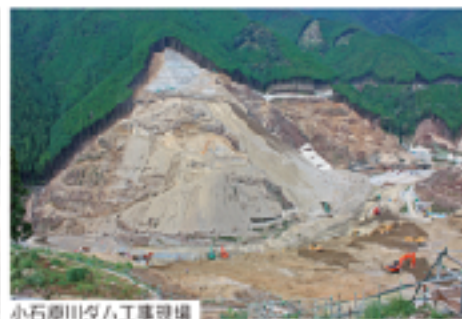
小石原川ダム工事現場
