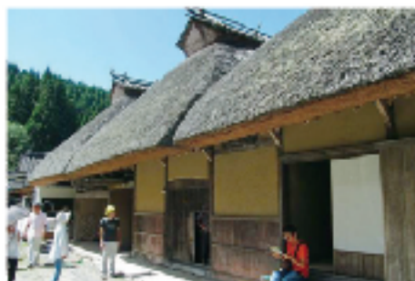
▲国指定重要文化財 平川家住宅
