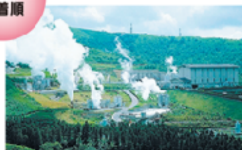
全国最大規模の九重八丁原地熱発電所
